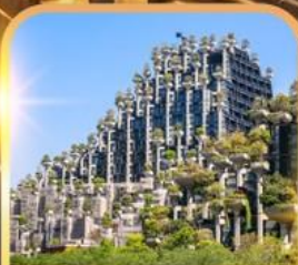
อาคารต้นไม้พันต้น
